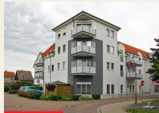
Der ehemalige Geschäftssitz der PWG in der Schillerstraße 2
