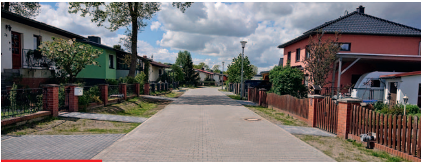
Die Sanierung der Mögelineer Ringstraße ist abgeschlossen.
