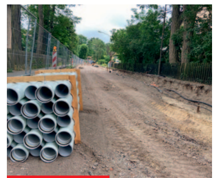
Seit April wird die Bunsenstraße grundhaft ausgebaut.
