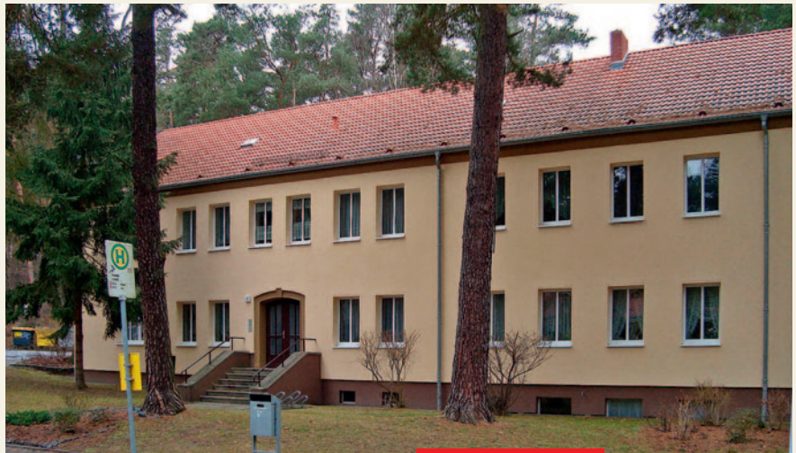
Straße der Freundschaft 1 nach der energetischen Sanierung ...
